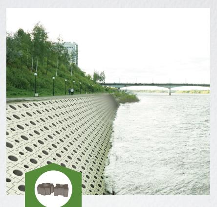
EROSION CONTROL OR RIVER SLOPE CONTROL BLOCKS
